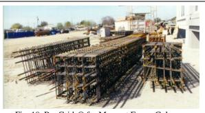
Fig. 19. BauGrids® for Moment Frame Columns
